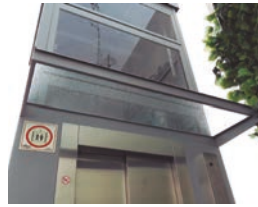
Roof over door (metal sheet or glass)
